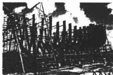
Concluída a edificação dos gabaritos das cavernas Base Naval de Aratu - Salvador (BA) - 04 / 11 / 98
